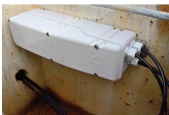
Installation im Kabelschacht
